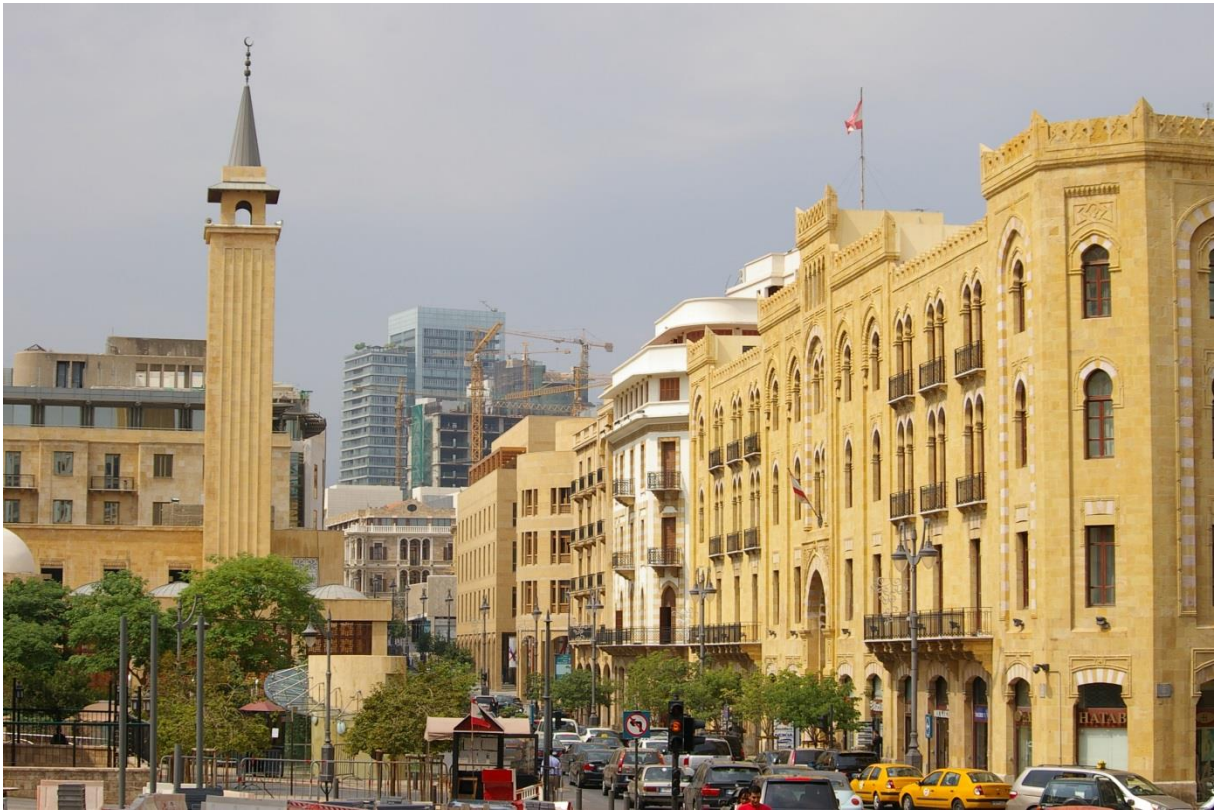
Der Wiederaufbau des Stadtkerns von Beirut ist fortgeschritten, hier die Rue Weygand. Foto: M. Pabst
